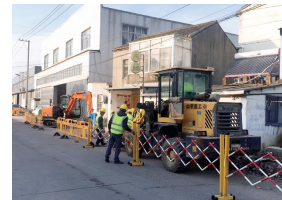
惠民工程——农村管网改造施工现场
